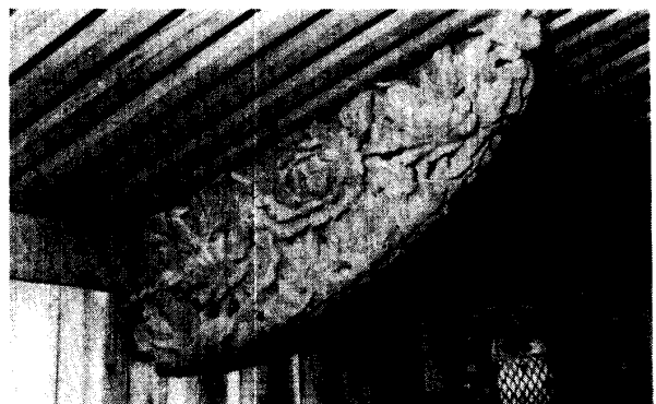
写真-7 もとの向拝柱の上部に残る手挟（たばさみ）
