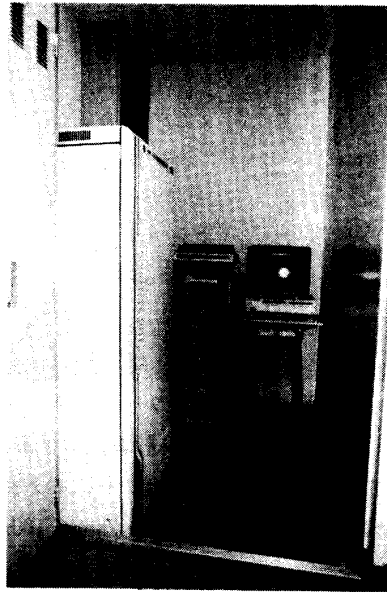
写真13 事務電算室に設置してある（左前方）ISDN対応デジタルPBX FETEX3100A，（左後方上）IDF（Intermediate Distribution Frame：中間分配用端子盤），（中）モデムブール1200bps，2400bps，（右）制御用パソコンFMR50FX/FA
