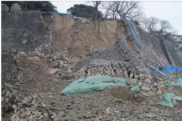
Fig.9 三ノ丸石垣の崩落状況 (下方より撮影)
