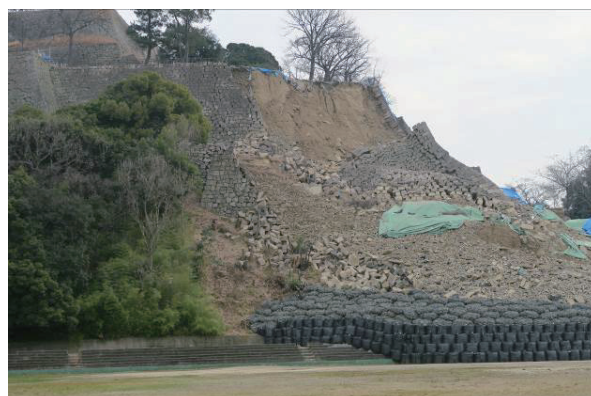
Fig.8 被災後の三ノ丸と帯曲輪の石垣（西面）
