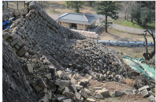
Fig.10 三ノ丸石垣の崩落状況 (上部より撮影)
