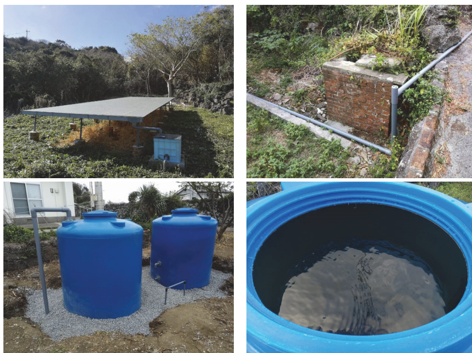
図8 雨水を水源とした小規模集落スマート給水システムの現状写真 雨水集水面「雨畑」(左上), 雨畑-雨水貯留槽間配管 (右上), 雨水貯留槽 3m³×2 基, 雨水貯留槽内の様子
