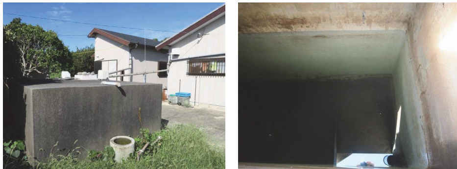
図2 長崎県五島市赤島内の一般的な戸建住宅（左）と雨水貯留槽内の様子（右）
