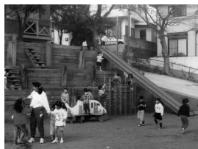
写真 4.25 グラウンド（園庭）と擁壁
