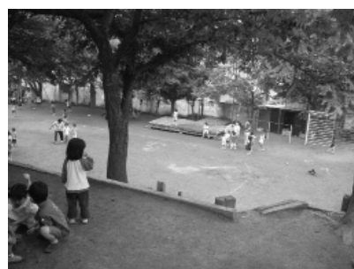
写真 4.24 擁壁の上部（園舎周り）
