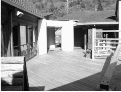
写真 4.36 分棟の保育室・遊戯室とテラス
