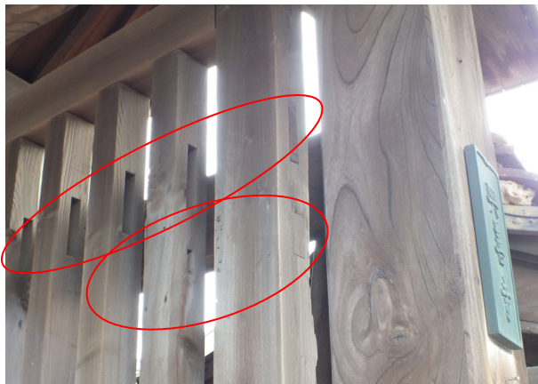
写13 扉表詳細 (上部の丸印は格子貫穴、下部が壺金穴と鋌痕)
