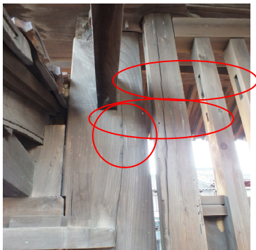
写14 扉裏詳細 (上の丸印は格子貫穴、中の丸印は壺金穴、下の丸印は柱肘金埋木と鋌穴)
