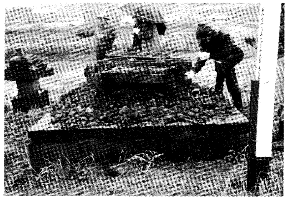
写真-2 基壇の解体工事中 (金津町教育委員会提供)
