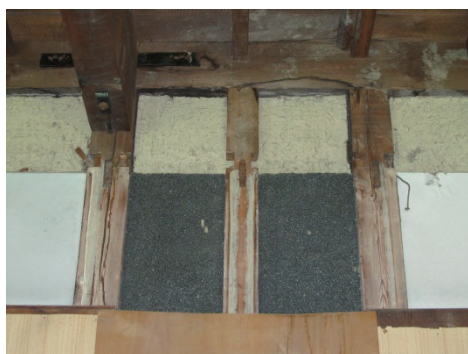
写真 05 柱に残る浅床の痕跡
