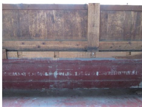
写真 08 土台に残る根太彫
