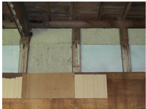
写真 04 柱に残る土壁の付着跡
