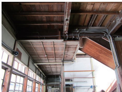
写真 01 階床梁に残る柱ホゾ穴 と土壁の付着痕
