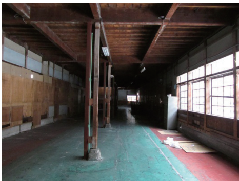
写真 03 階床梁に残る柱ホゾ穴と 土壁の付着痕
