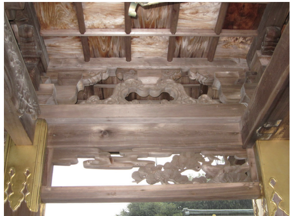
左側面前方柱間上部
