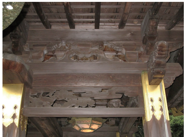
右側面後方柱間上部
