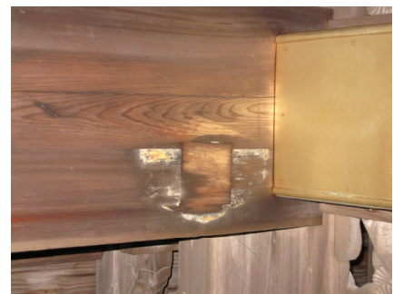
写真4 冠木に残る幣軸・藁座の痕跡
