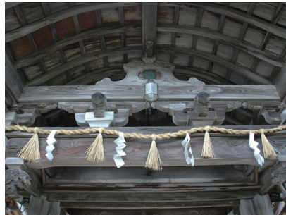
正面虹梁上部
