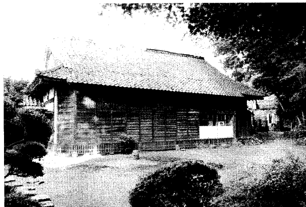
写真-2 背面外観
