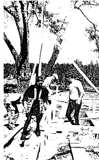
【写真12】スウェーデンにおける作業風景
